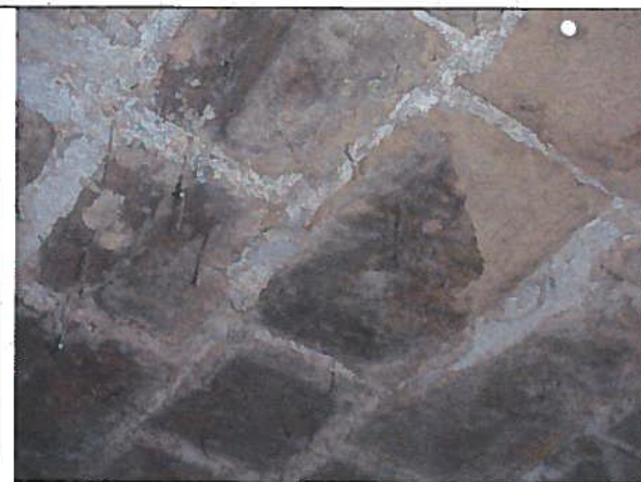
fig 9 : Joint pulvérulent et « mousseux », cave 1
