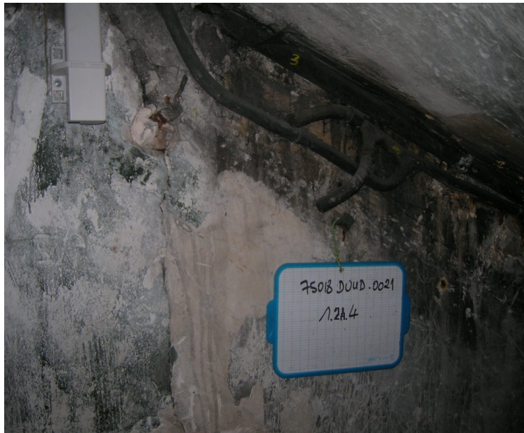
Photo 7920 CONTACT PLOMB - EAU EFFET DE PILE (Alternance de métaux) BRAS MORT EN PLOMB
